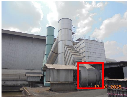
รูปที่ 32 ระบบเก็บเสียง (Silencer)
