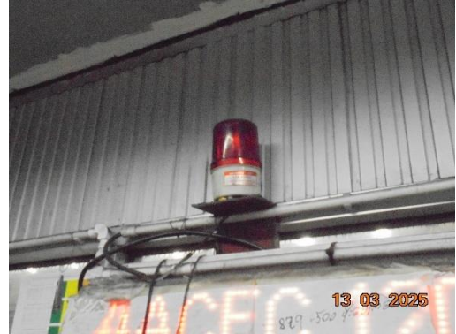
ระบบสัญญาณเตือนแบบแสง
