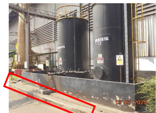
รูปที่ 24 รางรับน้ำรอบพื้นที่กักเก็บน้ำมัน
