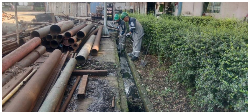
รูปที่ 28 การขุดลอกท่อและวางระบายน้ำ
