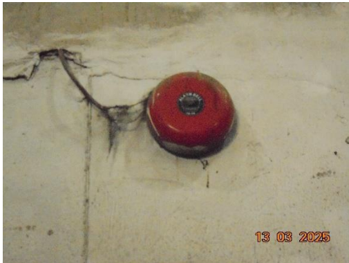
ระบบสัญญาณเตือนแบบเสียง
